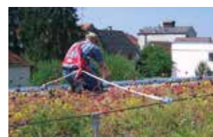
OPTISAFE TYP L lina Lina zabezpieczająca umieszczona w linii równoległej do krawędzi dachu, przeznaczona do dachów zielonych i żwirowych.
